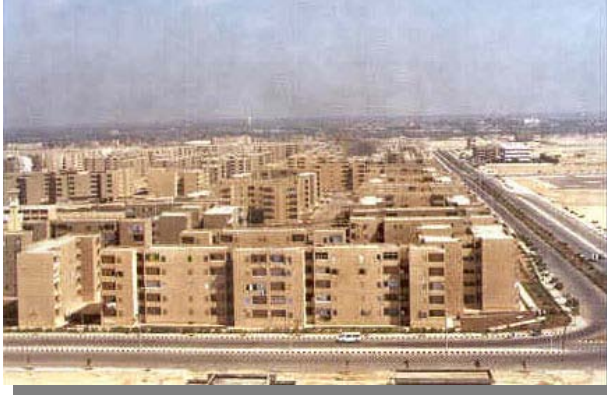
شكل (3) يوضح مشروع إسكان منخفض التكاليف - مدينة بنى سويف الجديدة.
