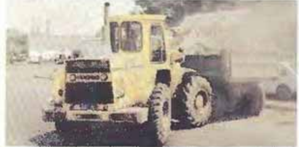
تحميل مخلفات المباني بواسطة لودر في سيارة قلاب
