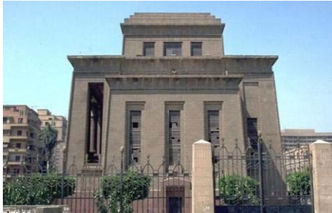
(شكل 2) ضريح الزعيم سعد زغول (مثال للبناء على الطراز الفرعوني)
