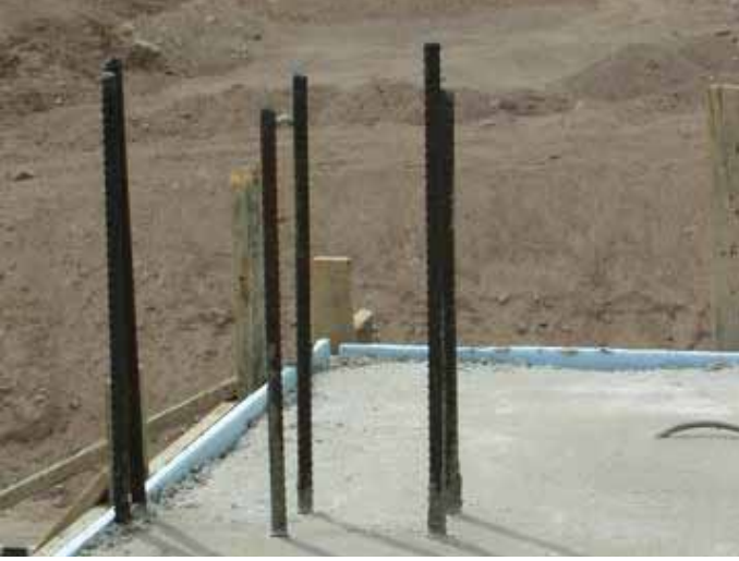
معالجة جسر حراري: ٣ سم من البوليسترين في القوالب قبل صب الخرسانة
