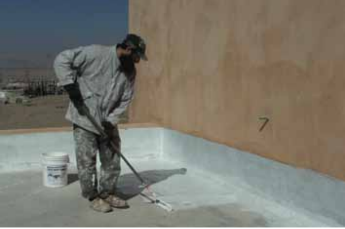
السقف الأبيض يقلل من حمل التبريد
