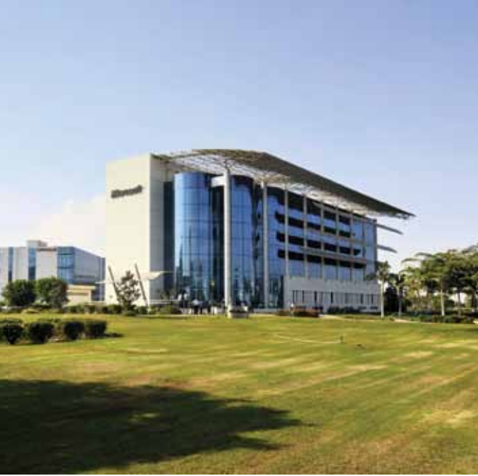
يتلقى السقف أعلى إشعاع شمسي و لذلك فإن التظليل هو حل جيد- مبنى إداري بالجيزة، مصر
