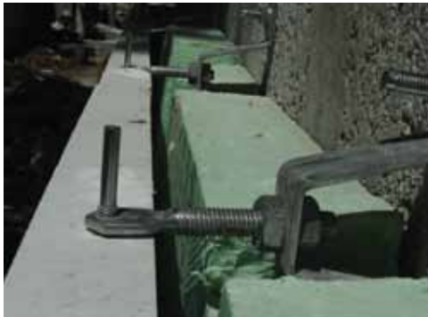
بناء حائط - السفارة الهولندية - الأردن
