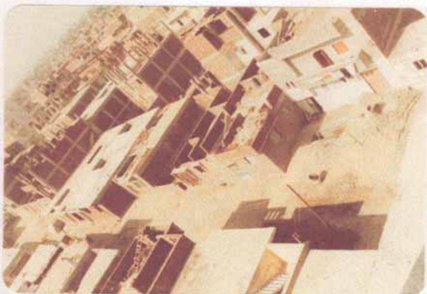
مراحل تطور حركة البناء والتشييد بمنطقة حي السلام أثناء تنفيذ المشروع
