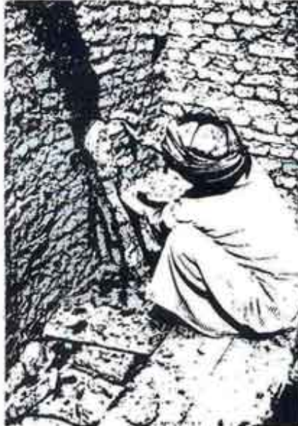
◀ بناء القبوات باستخدام الطوب الاحمر .
