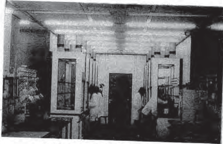
شكل (١٠٥) مجموعة خزائن الأبخرة بأحد المعامل . مبنى الطب النظري بجامعة هيدلج .
