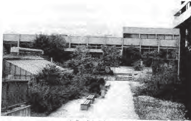
شكل (٨٣) جامعة هيدلبرج : مبنى المدرجات ويرى على اليسار البيت الزجاجي .
