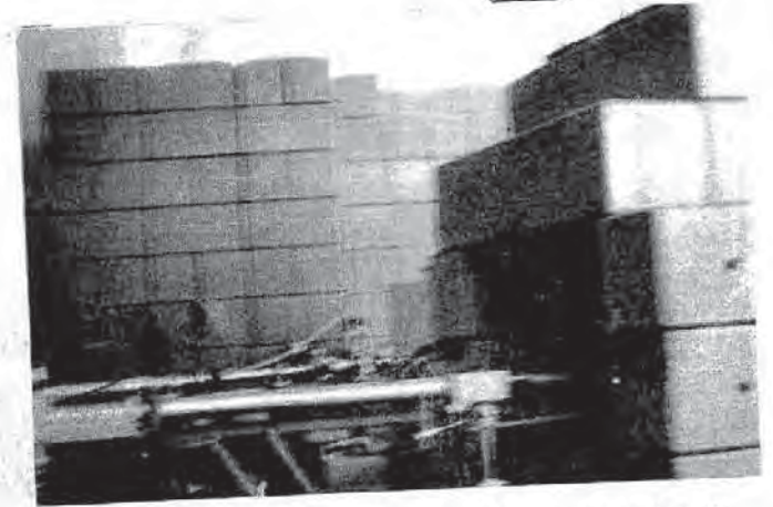
شكل (١١٨) جامعة هيدلج: وحدات الرصاص بداخل مبنى المفاعل النووي التابع لوحدة أبحاث السرطان.
