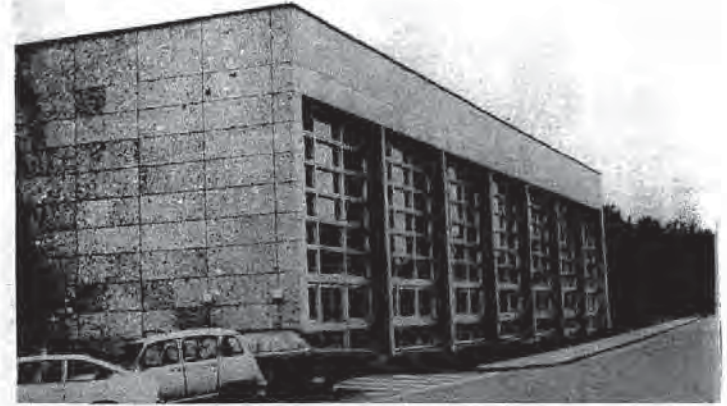
شكل (٦١) منظور خارجي لمبنى الهنديزيوم المعلق - جامعة هيدلبرج - المواصلات الخارجية من البلاطات الخرسانية سابقة الصب
