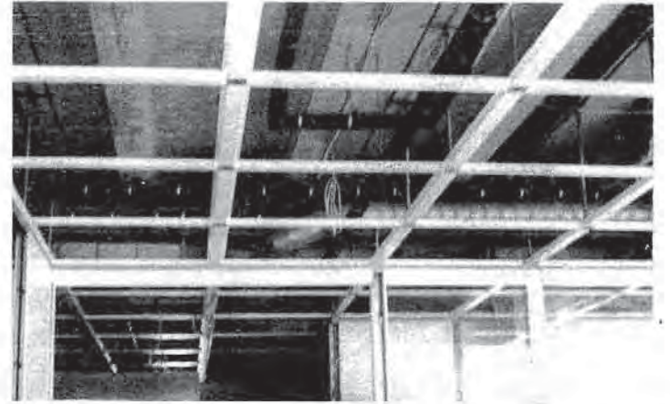
شكل (١٠٣) التوحيد القياسي وإستعمال المعدل الواحد واضح في هذه الصورة حيث المجاري التي توجب عليها بلاطات السقف والمجاري الرأسية التي توجب عليها الابواب وباريهات القواطع الداخلية .
