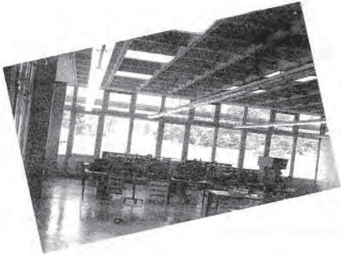
شكل (٢٧) جامعة أولم: أحد الورش الكهربائية (لاحظ أن المعدل أكبر من ٢,٧ م في أحد الاتجاهات على الأقل لهذا الجزء الخاص من المبنى).
