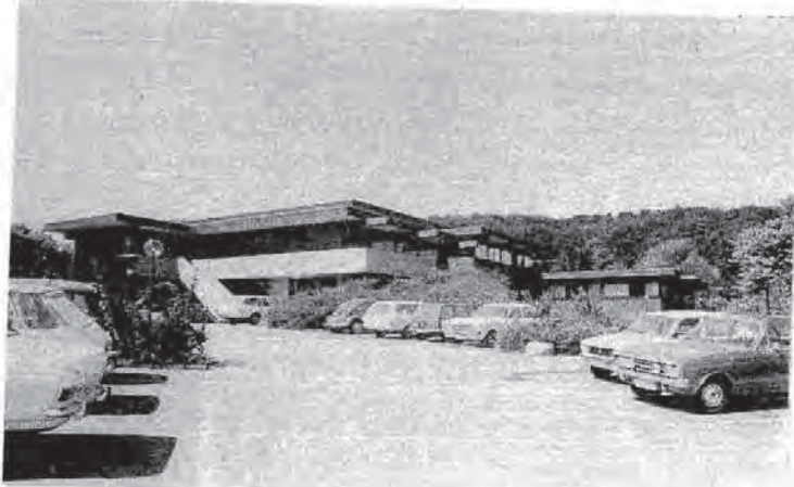
شكل (١٨٢) المكتب الهندسي جامعة كونستانز مبني للدخول الخاص للمدير المكتب من موقف السيارات.
