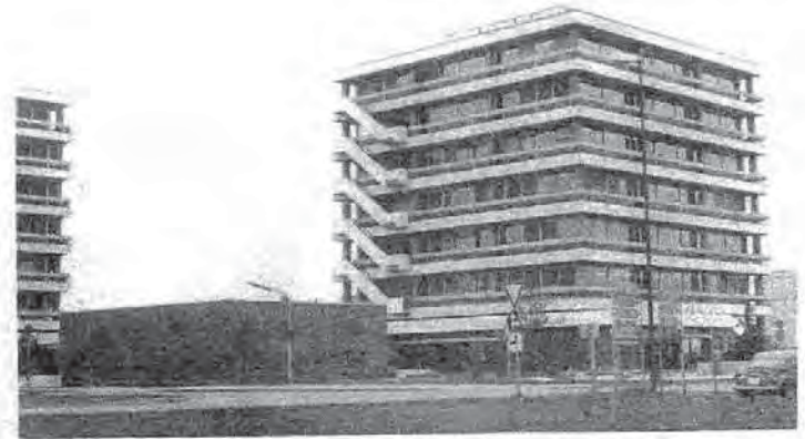
شكل (٧٣) جامعة هيدلج: أحد المباني المبنية في الخمسينيات ويرى سلم الهروب وممرات الهروب خارج المعامل.
