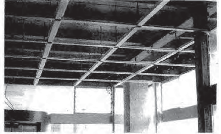
شكل (١٠٢) صورة تبين عماري بلاطات السقف والتي عرضها ٦٠ سم .
