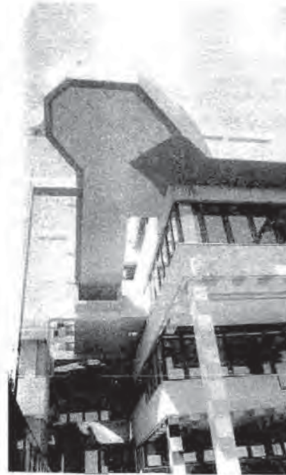
شكل (١٥٤) جامعة كونستانز: تراس العلم الرئيسي. نموذج لتحرير التصميم وخروجه عن الأشكال الثابتة والتكرار الناتج من التوحيد القياسي. فهو يجمع بين مميزات التوحيد القياسي والأجزاء سابقة التصنيع وبين تميز التصميم وتجديده واختلافه عن بقية المباني الجامعية في نفس الولاية.
